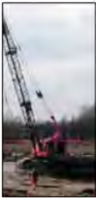
Il cantiere per il nuovo casello
