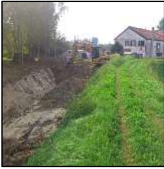
Lavori in corso sullo scolo Castellaro a Fiesso d'Artico
