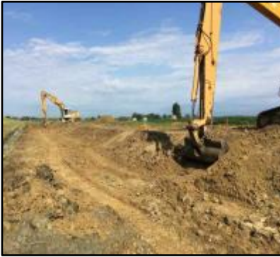
Sopra, ruspe in azione a Mira per i lavori di potenziamento dell'impianto idrovoro di Dogaletto; sotto: i lavori realizzati dal Consorzio all'impianto idrovoro di Carmason in comune di Quarto d'Altino.
