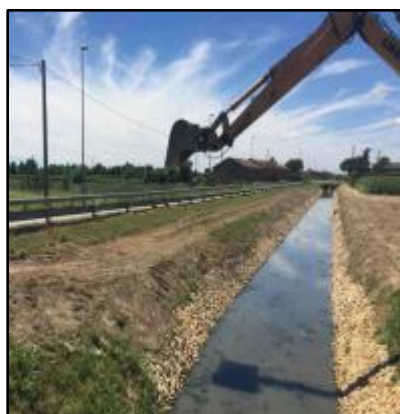
Sopra, ripristino argini franati lungo lo scolo Fossa del Palo a Campagna Lupia; a destra: il tratto dello scolo Desman a Santa Maria di Sala ripristinato. Sotto, il cantiere per la riqualificazione dello scolo Zermason a Marcon.
