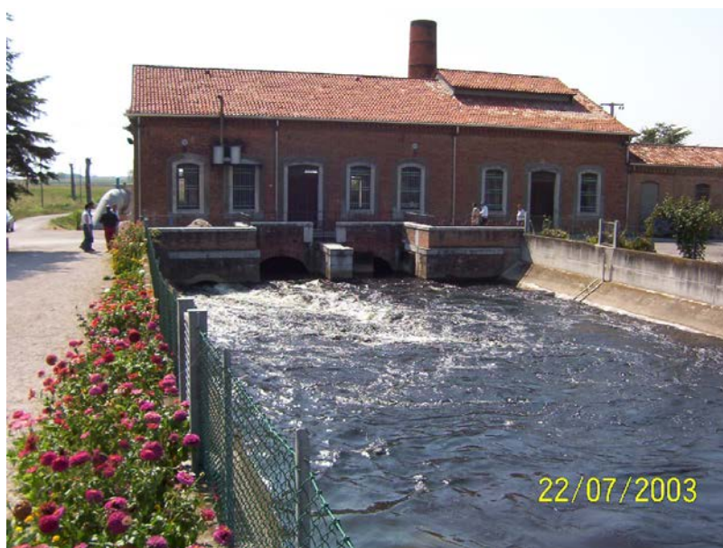
Impianto idrovaro di Lova – Vista del bacino di scarico con pompe in azione.
