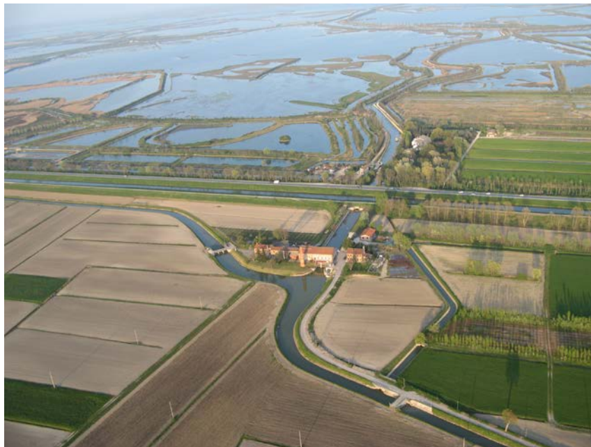
Impianto idrovaro di Lova – Veduta aerea del manufatto e della Laguna di Venezia.
