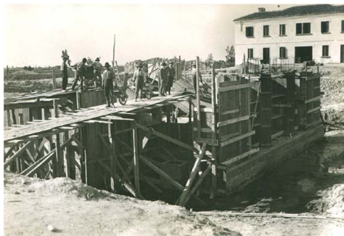
1927. Lavori di costruzione dell'impianto idrovoro lato sud verso il fiume Dese. Sullo sfondo la casa del custode
