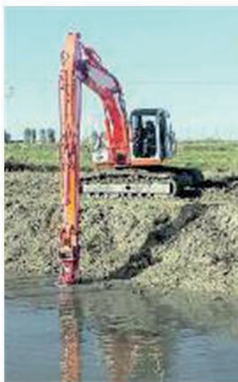
POTENZIAMENTO Conclusi i lavori al pozzo Castellan Nuovo
